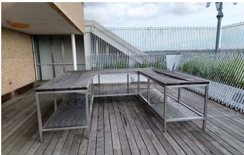
På Ørestad Skole er der et udekøkken men ikke vandtilførsel til køkkenet.
