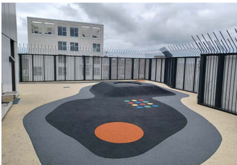
På Lille Arena er der lagt en gummibelægning på hele taglegepladsen.
