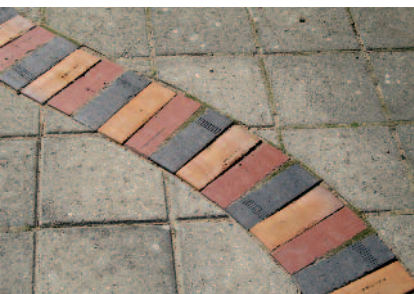
Et slynget bånd af gule, røde og sorte teglsten. Båndet er skåret ned i eksisterende betonflade Foto Dina Ingerslev Heldt
