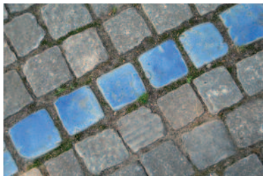
I form og størrelse som chaussesten. Det er stentøj, der er specialfremstillet. Foto Dina Ingerslev Heldt
