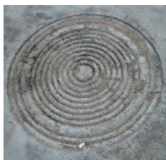
Relief i insitu-støbt betonflade. Vand samler sig i rillerne. Foto Dina Ingerslev Heldt
