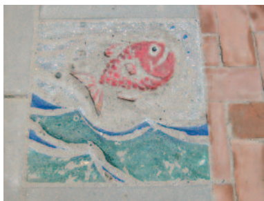
Relief flise i indfarvet beton. Foto Lene Nielsen
